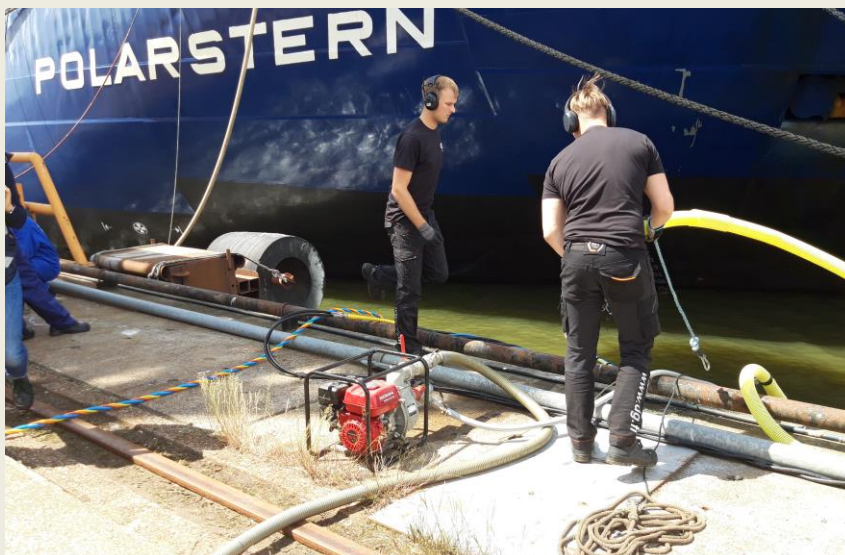
Abbildung 28: Vorbereitungen für eine Reinigung auf einer biozid-freien Hartbeschichtung
