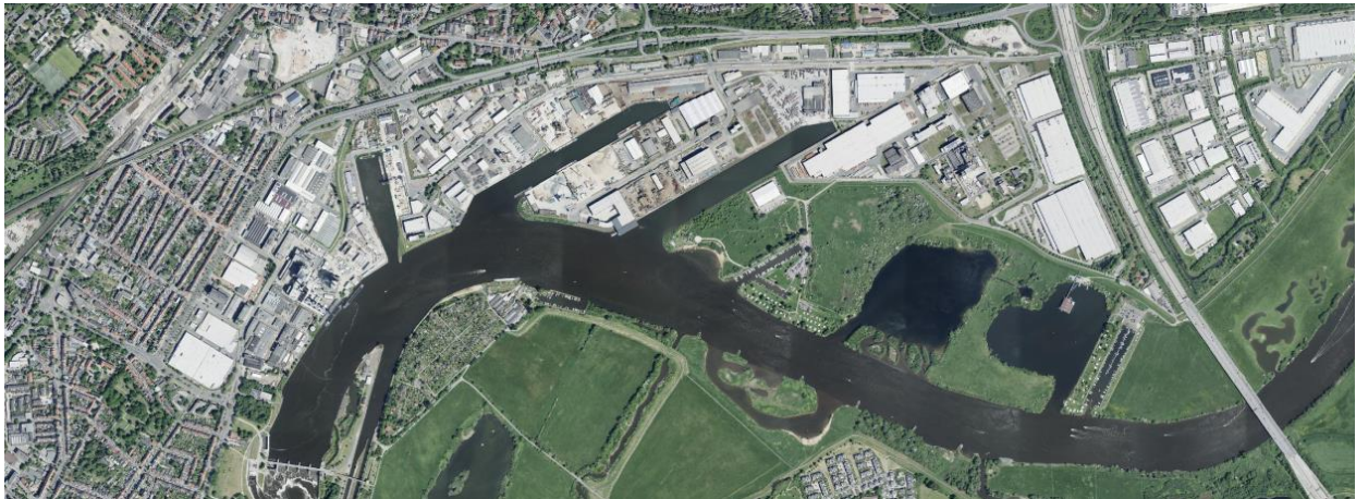
Abbildung 10: Luftaufnahme des Weserhafens Hemelingen (nur Binnenschifffahrt)
